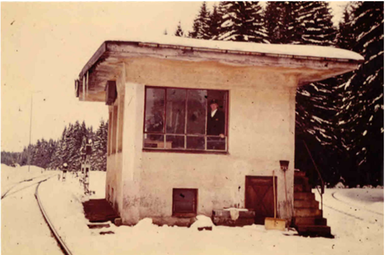
Stellwerk 1 von Süden
