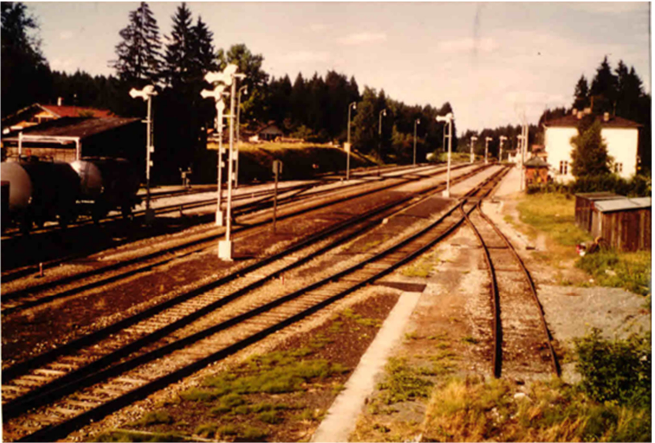
Blick Richtung Norden
